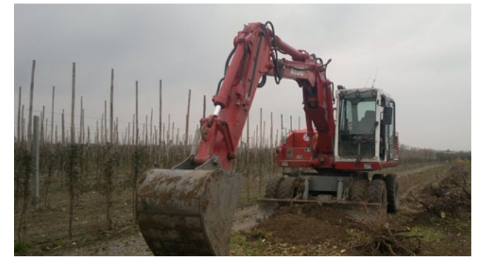
Fot. 4. Wyrwanie drzew, zasypywanie dołów
